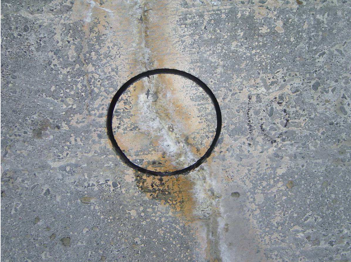
Mynd 3. Borkjarni 10 og reyndar kjarni 9 voru boraðir á sprungu.
