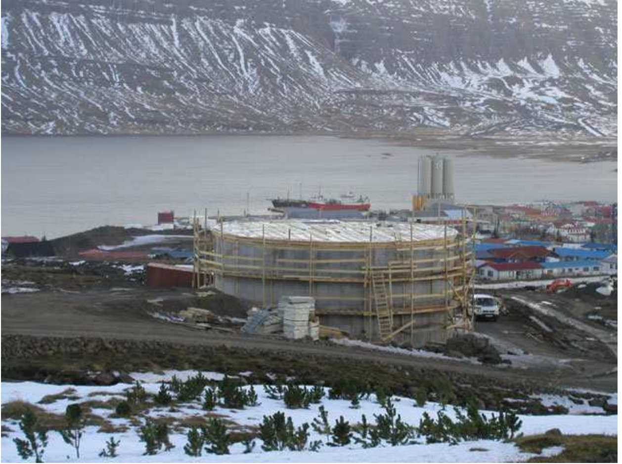
Mynd 23. Ferskvatnstankur á Reyðarfirði í byggingu um vorið 2004. Steypan er með 1,5 % XYPEX admix
