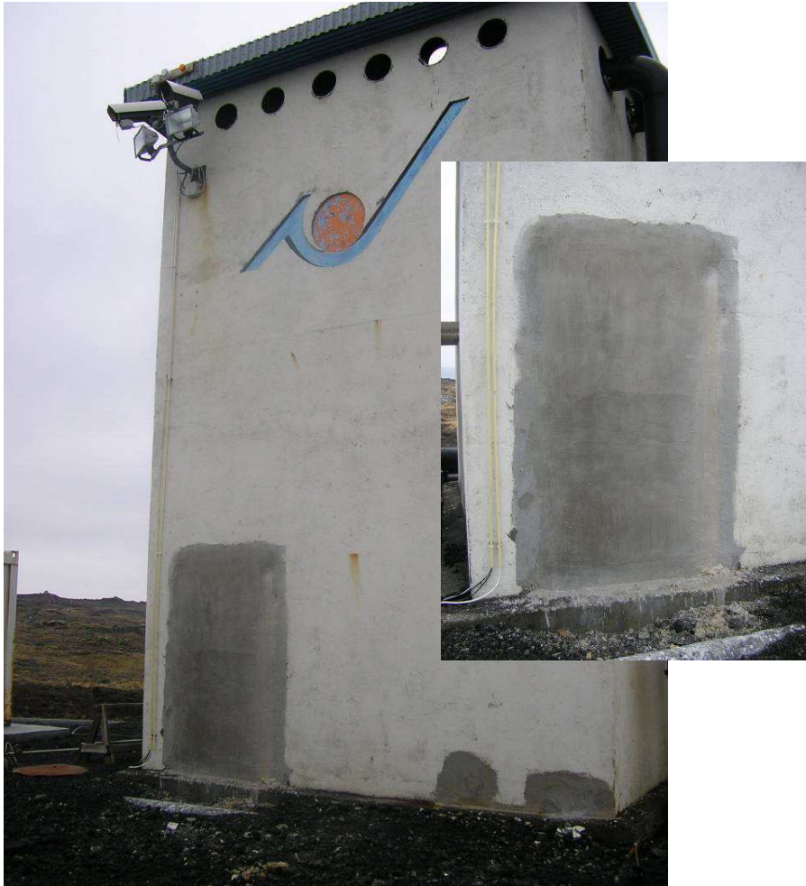
Mynd 22. Hurðarop á vatnstank eftir meðhöndlun með XYPEX. Engan leka er að sjá í samskeytum milli hurðarops og veggjar.
