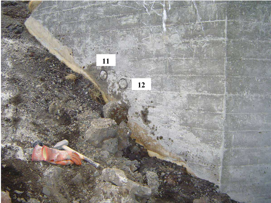
Mynd 2. Staðsetning borkjarna 11 og 12 í vestari landstöpli.
