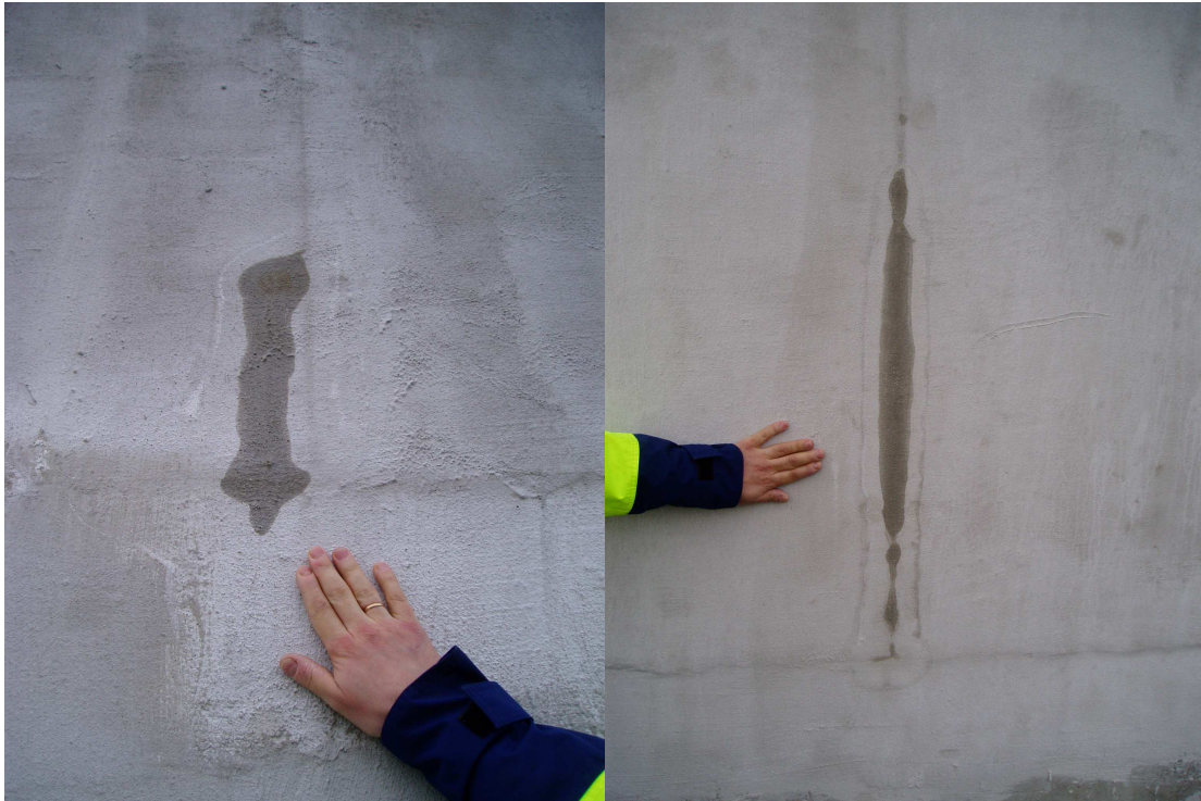
Mynd 25. Leki í ferskvatnstanki í Reyðarfirði, myndin var tekin 31-3-2005
