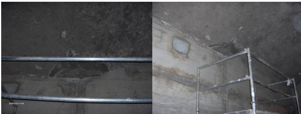
Mynd 26. Svæði sem hefur verið meðhöndlað með XYPEX Patch og Plug og Concentrate.
