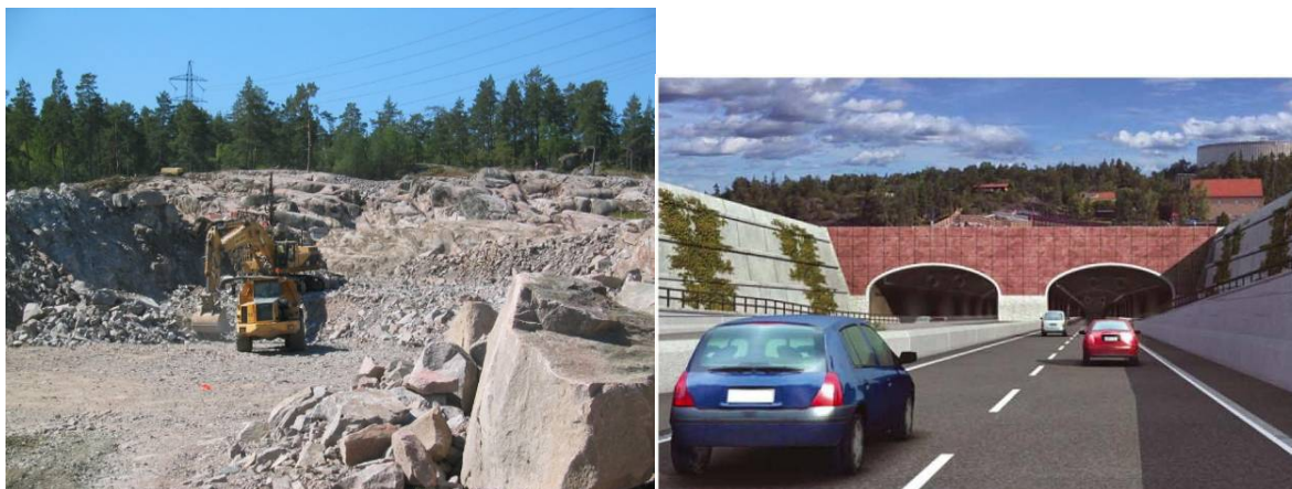
Mynd 83. Törnskogstunneln í Sollentuna kommun í norður Stokkhólmi.
