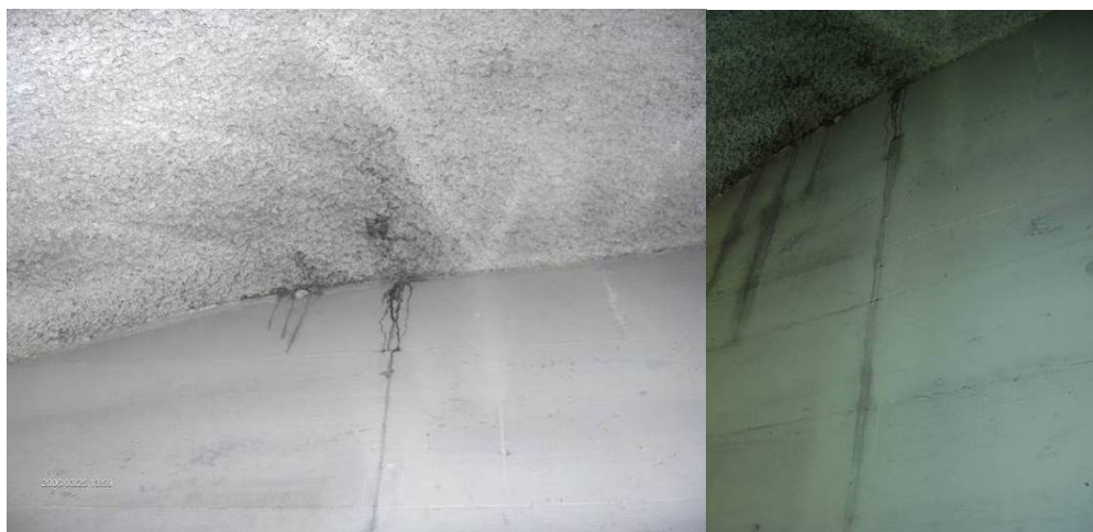
Mynd 24. Leki sem byrjaði eftir að sprunga var þétt hinum megin við vegginn.
