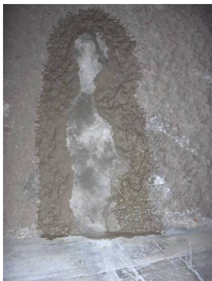
Mynd 22. Viðgerð með Patch og plug og Concentrate.
