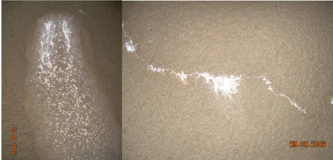
Mynd 93. Lekablettur tv og sprunga th með hvítar útfellingar. Mögulegt er að útfellingar tengist notkun Xypex í sprautusteypunni.
