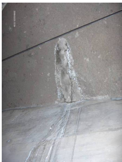
Mynd 23. Viðgerð með Patch og plug og Concentrate. 24 tímum eftir að vatnsþétti efni var borið á.
