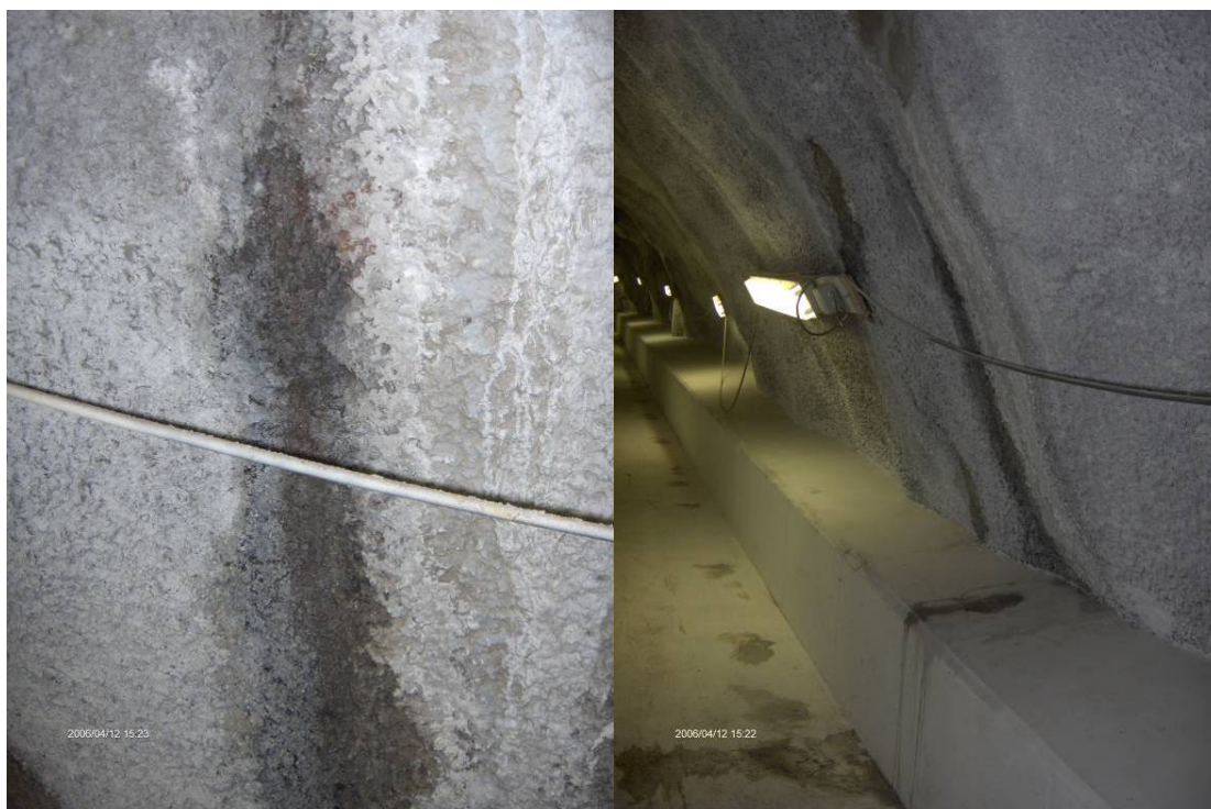
Mynd 18. Lekablettur 2 frá 12-4-2006. Leki um sprungu til hliðar við meðhöndlað svæði.
