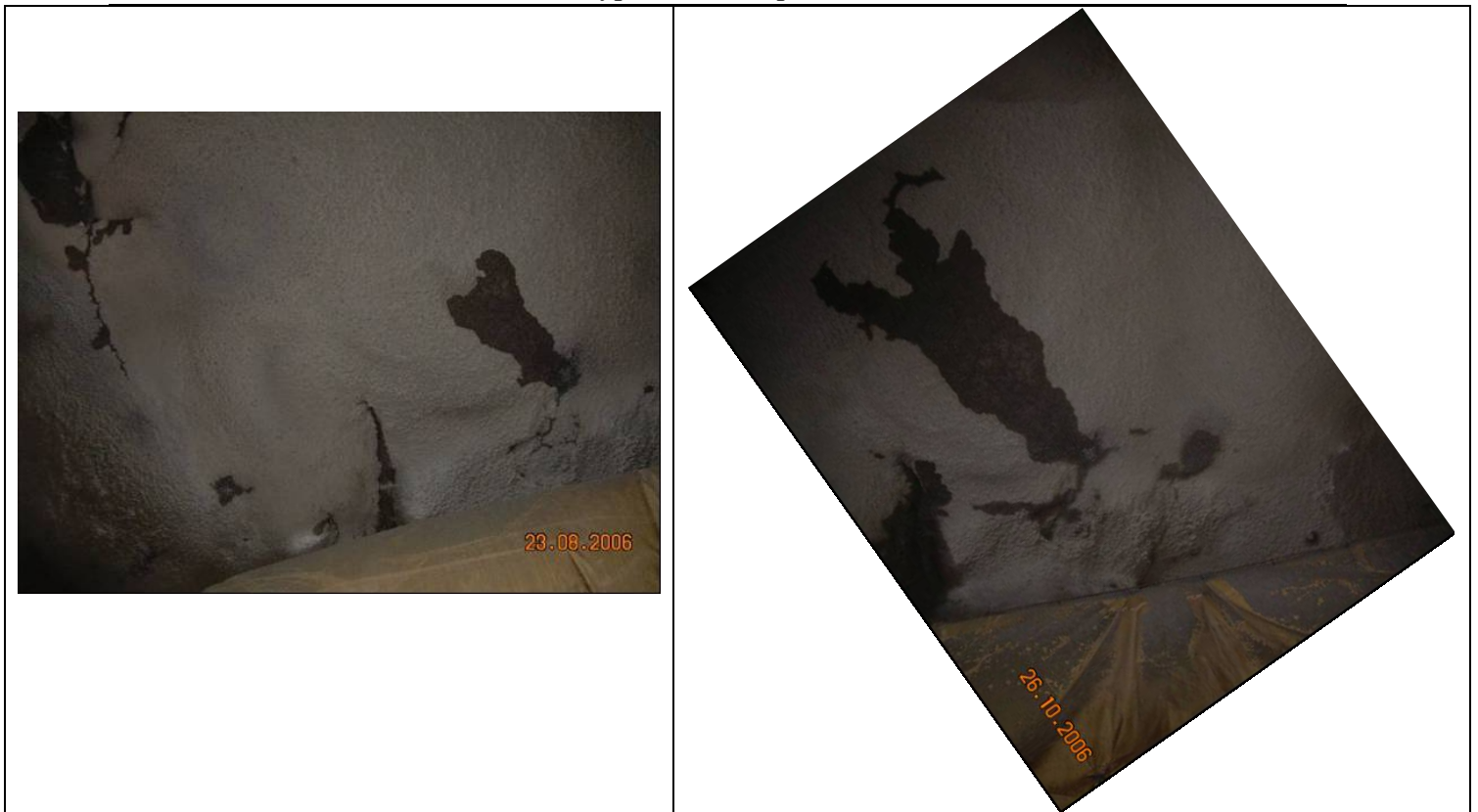
Mynd 44. Lekablettur D, samanburður á aðstæðum eftir 1 og 3 mánuði frá yfirsprautun.
