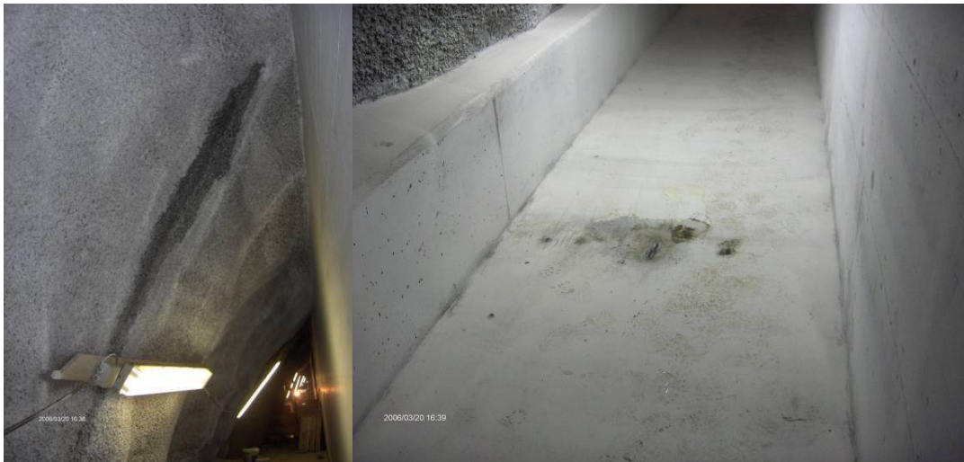
Mynd 8. Lekablettur 4 áður en XYPEX Concentrate var borið á svæðið. Pollur á gólfinu sem sýnir lekann í svæði 4.
