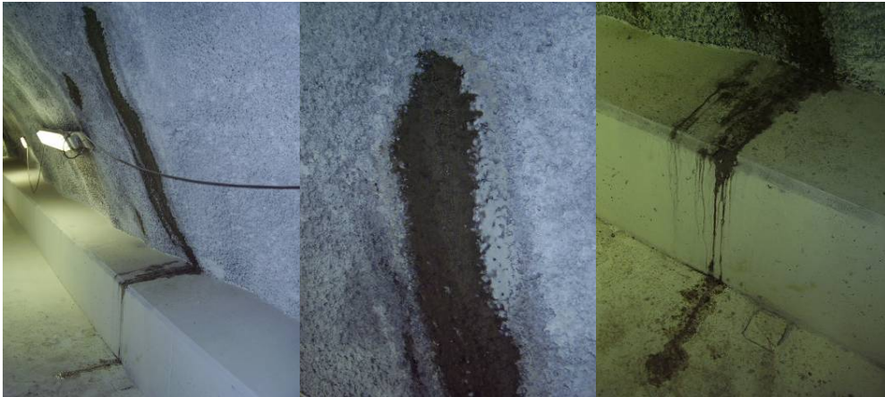
Mynd 11. Lekablettur 3 (minni), lekablettur 2 (stærri) og lekinn frá blett 2. Eftir að búið er að bera tvö lög af XYPEX Concentrate á svæðið. 24 tímar frá seinni umferð.
