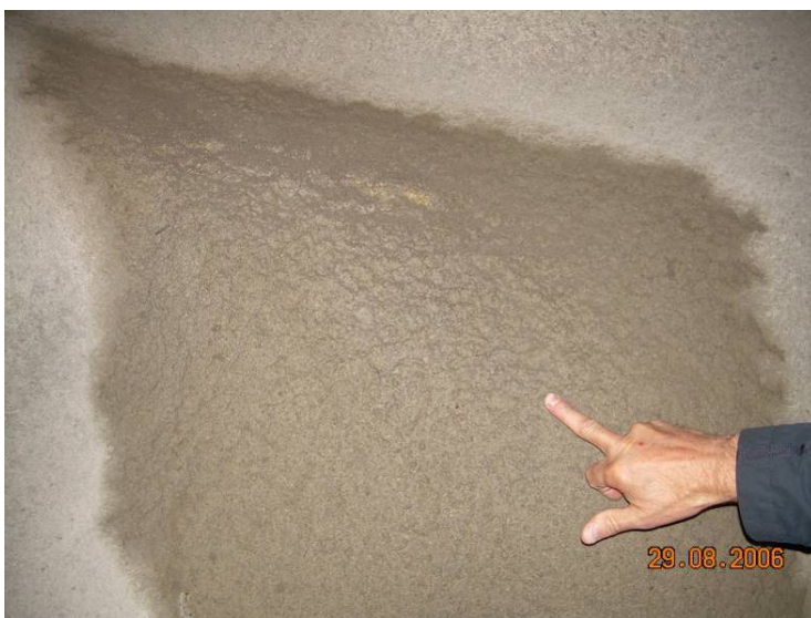
Mynd 92. Lekablettur í sprautusteypu í nærmynd.
