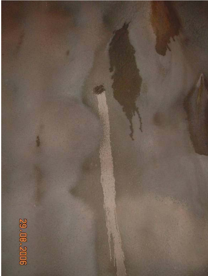
Mynd 91. Lekablettur í sprautusteypu sem virðist hafa þéttst.
