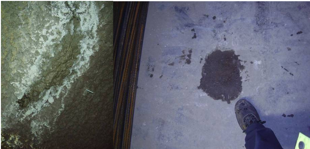
Mynd 12. Lekablettur 1. Tiltölulega lítill lekablettur og leki á gólfinu. Eftir að búið er að bera tvö lög af XYPEX Concentrate á svæðið. 24 tímar frá seinni umferð.
