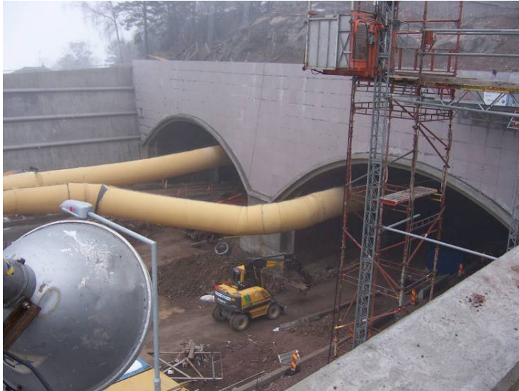
Mynd 84. Gangnamunni í Törnskogstunneln.
