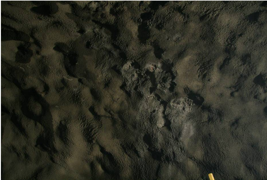
Mynd 28. Í loftinu í stöð 2550 er tiltölulega mikill leki. Stöðugt dropar úr loftinu og erfitt er að fá steypuna til að tolla uppi.
