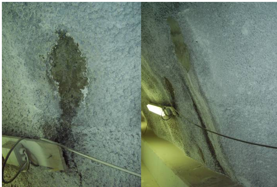
Mynd 16. Lekablettur 3 (minni) og lekablettur 2 (stærri). Búið er að bera tvö lög af Concentrate og eitt lag af Patch og Plug. 16 sólarhringar frá upphafi.
