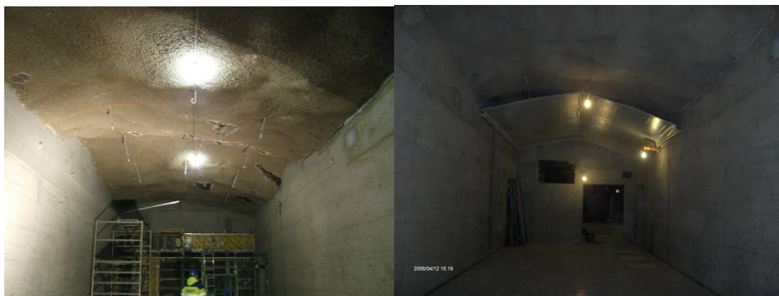
Mynd 19. Uppsetning á vatnsvarnaklæðningu.
