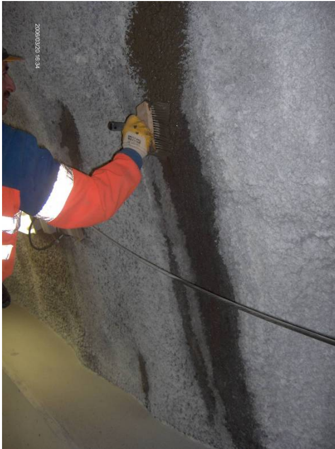
Mynd 5. Svæði 2. Nokkur leki er í efri hluta svæðis.
