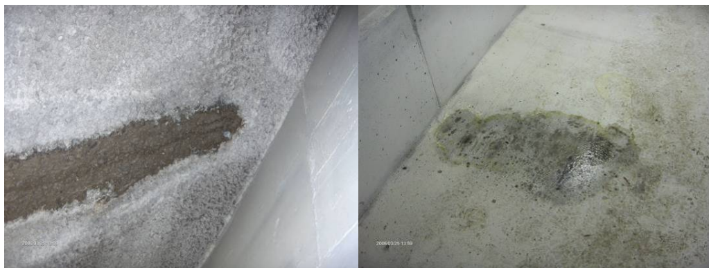
Mynd 15. Lekablettur 4. Búið er að bera tvö lög af XYPEX á svæðið og lekinn á gólfinu. Um 3 sólarhringar eru frá seinni umferðinni.
